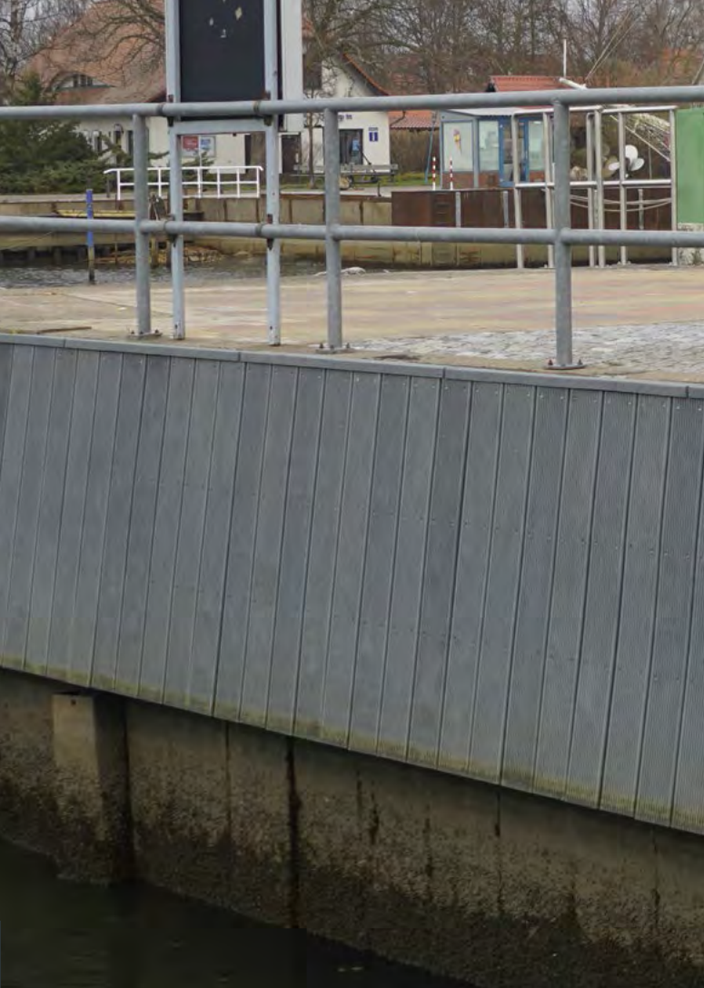
SPUNDWANDVERKLEIDUNG MIT LAUFBOHLE
